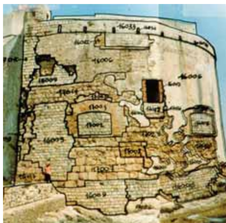
Letture stratigrafica del prospetto occidentale del Castello della Colombaia (Vultaggio 1993)
